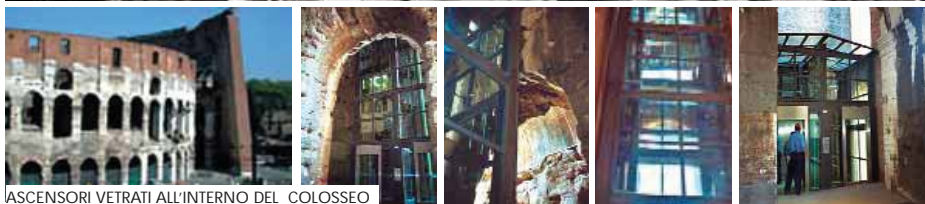
ASCENSORI VETRATI ALL'INTERNO DEL COLOSSEO
