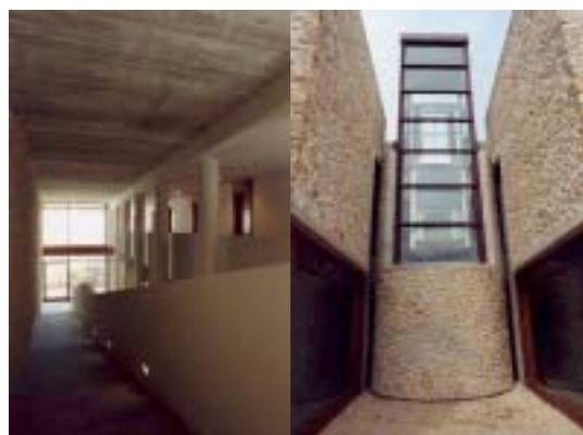
Ostello della gioventù di Sant'Alessandro a Soffia: foto della rampa, foto dell'ascensore
